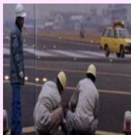
灯火の交換作業
